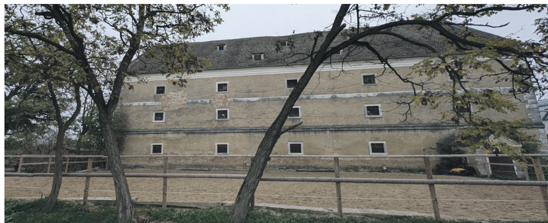
Schüttkasten Essling, einst Getreidespeicher des Schlosses
